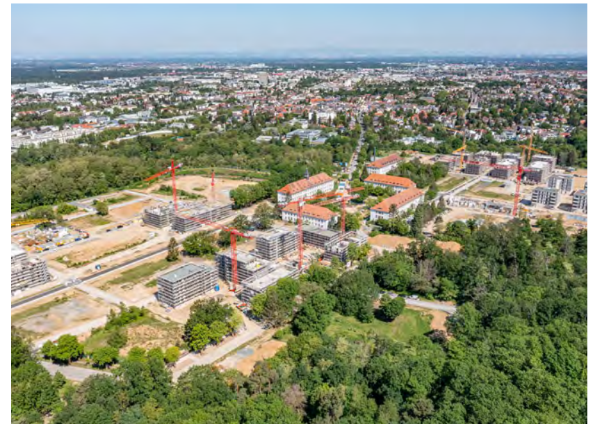
Große Baufortschritte im Ludwigshöiviertel: Ein Bauprojekt reiht sich an das nächste.
