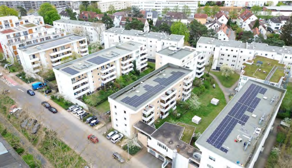
Die PV-Anlagen in der Holzhofallee sind mit einer Gesamtleistung von 111 kWp eine der größten Mieterstromanlagen in Darmstadt. In vier Teilanlagen sind 270 Module installiert. Die Anlage kann bis zu 100.000 kWh erzeugen.
