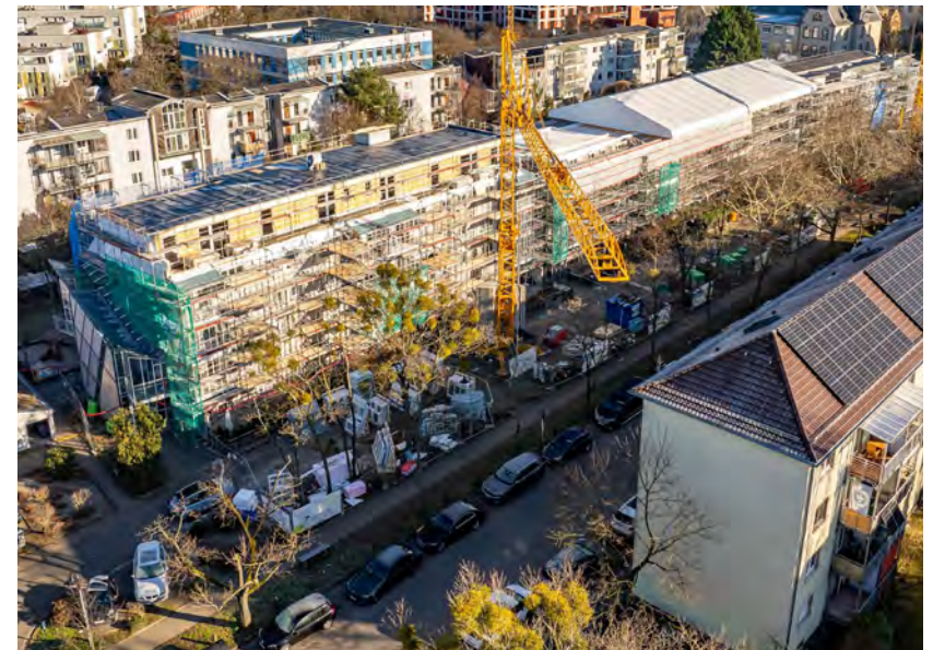
Die Erneuerung des „Schmetterlingsdachs“ fordert besondere Maßnahmen, wie ein Zelt zum Schutz während der Bauarbeiten.
