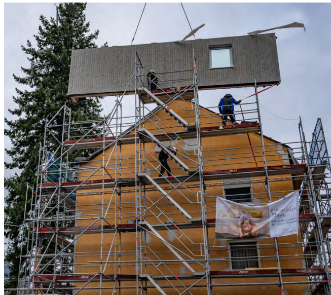
Aufwendiges Aufmaß, passgenaues Ergebnis: Damit vorgefertigte Fassadenelemente vor Ort sitzen, steckt viel Planungsarbeit in jedem Millimeter.
