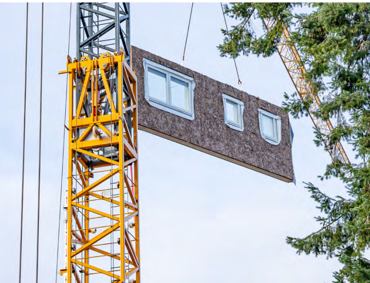
Aufwendiges Aufmaß, passgenaues Ergebnis: Damit vorgefertigte Fassadenelemente vor Ort sitzen, steckt viel Planungsarbeit in jedem Millimeter.
