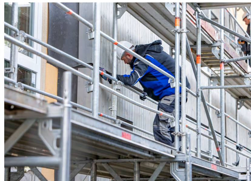
Mitten in Darmstadt, mitten im Wandel: Die Baustelle am Donnersbergring 21–25 ist das erste Pilotprojekt der bauverein AG zur seriellen Sanierung.
