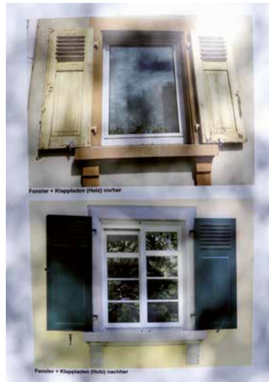
Die denkmalgerechte Sanierung ist kaum zu übersehen.
